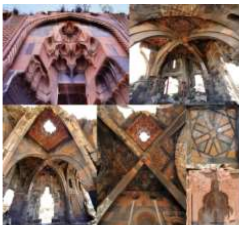
Şəkil 8. Karvansarayın qalıntıları, baş tağı və tavan örtüsünün görünüşü (4,13)
